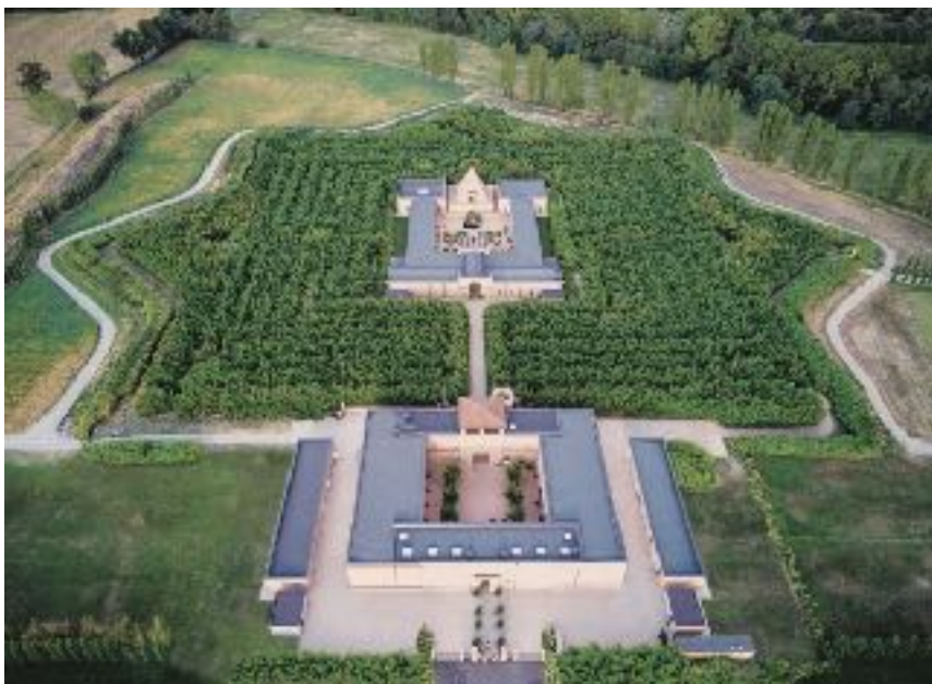
Vista aérea de Laberinto, lado oeste
